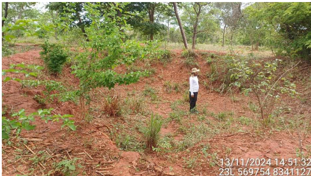
Figura 11 – Barraginha implantada para retenção de sedimentos e águas pluviais.
